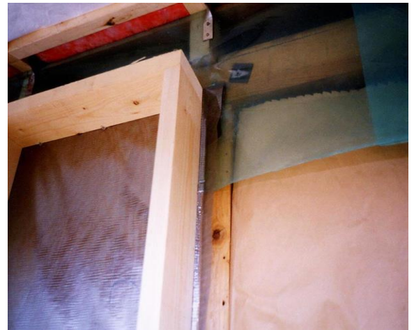
2階壁パネル上
